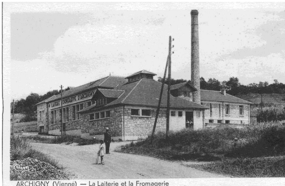
ARCHIGNY (Vienne) — La Laiterie et la Fromagerie
